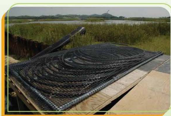
地源熱泵空調系統是由高密度聚乙烯管道組成
